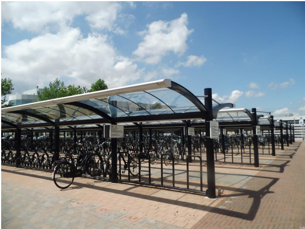
Fietsenstalling station Schothorst
